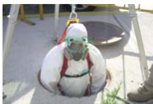
Secuencia de los trabajos de inspección llevados a cabo.
